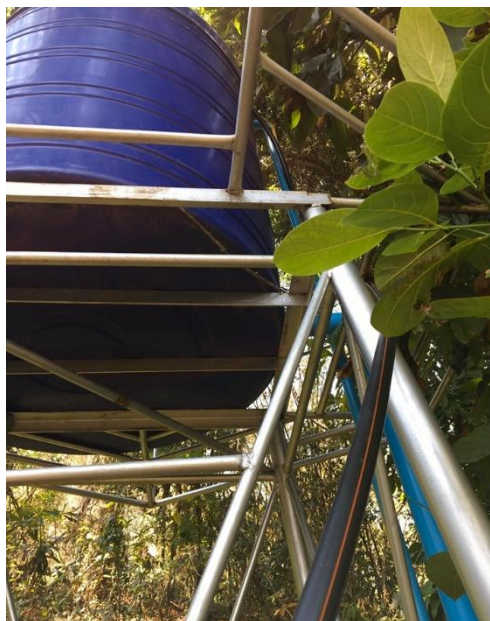
ภาพ ก-6 เดินท่อส่งน้ำจากปั้มน้ำไปยังแทงค์น้ำ
