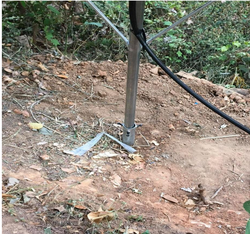
ภาพ ก-1 การติดตั้งเสาเพื่อเป็นฐานรองรับแผงโซลาร์เซลล์
