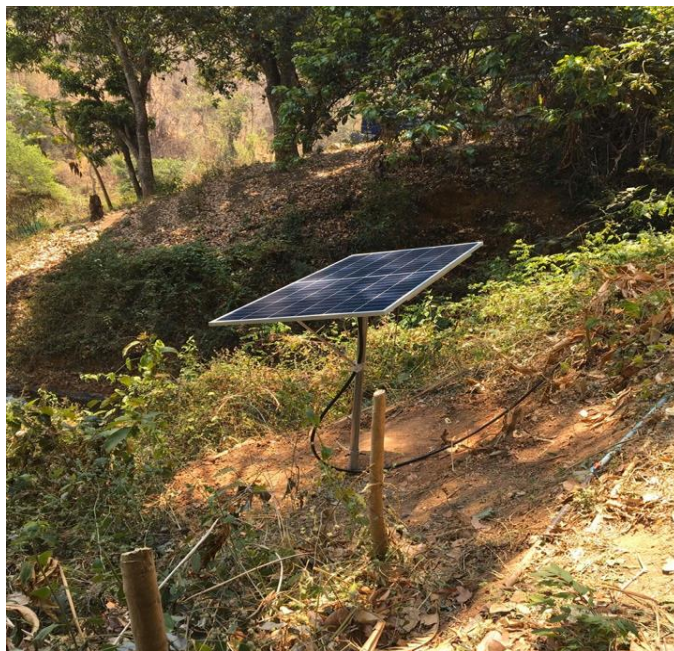
ภาพ ก-2 ติดตั้งแผงโซลาร์เซลล์โดยหันแผงไปทางทิศใต้
