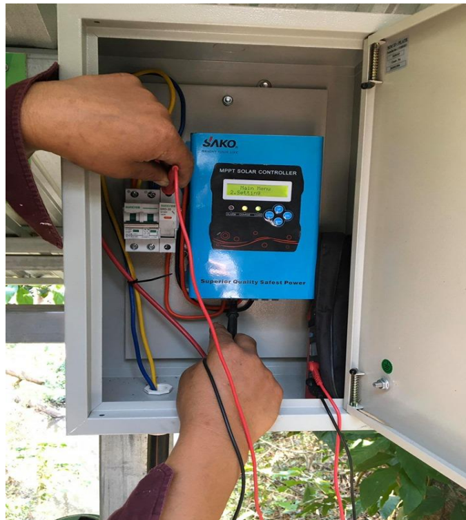
ภาพ ก-4 ทำการติดตั้งเบรกเกอร์ดีซีและชาร์จเจอร์
