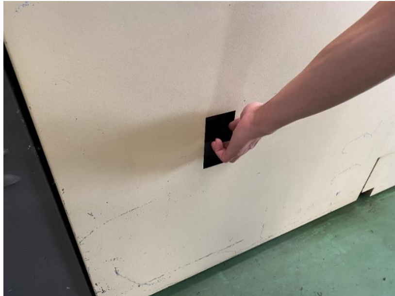
ภาพ 4.25 การดัน Breaker ขึ้น
