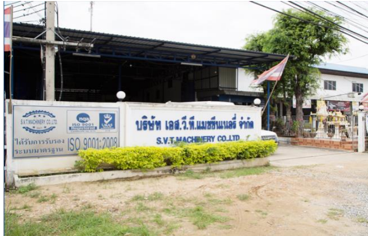
ภาพ 3.1 ที่ตั้งบริษัท เอส.วี.ที. แมชชีนเนอรี จำกัด ที่มา : http://www.svtmachinery.com
