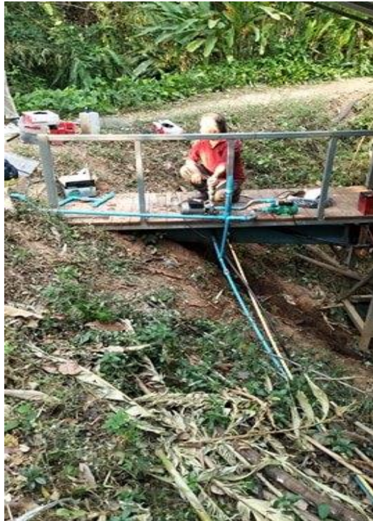
ภาพ ก-7 ทดสอบปั้มน้ำ
