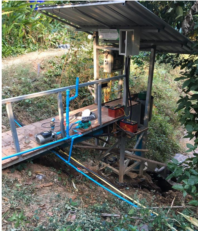
ภาพ ก-5 ติดตั้งปั้มน้ำ
