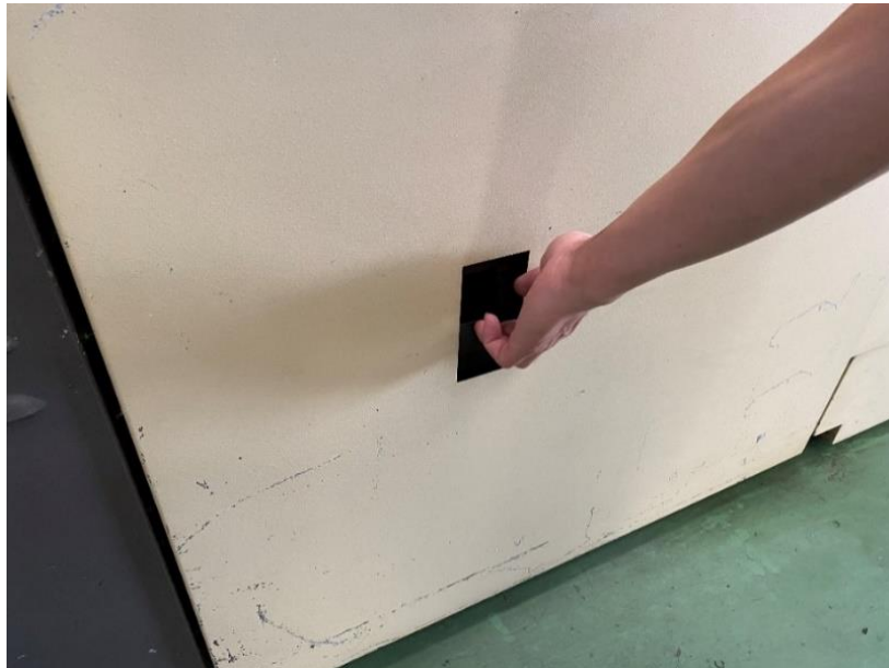
ภาพ 4.26 การดัน Breaker ขึ้น
