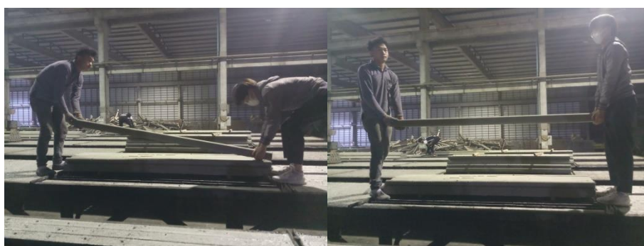
ภาพ 5.8 ทำทางการยกเสาเพื่อแป็ค โดยใช้คน 2 คน
