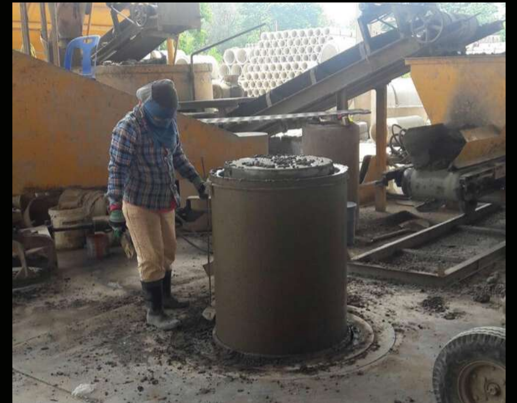
6.กระบวนการอัดขึ้นรูป ท่อคอนกรีต
